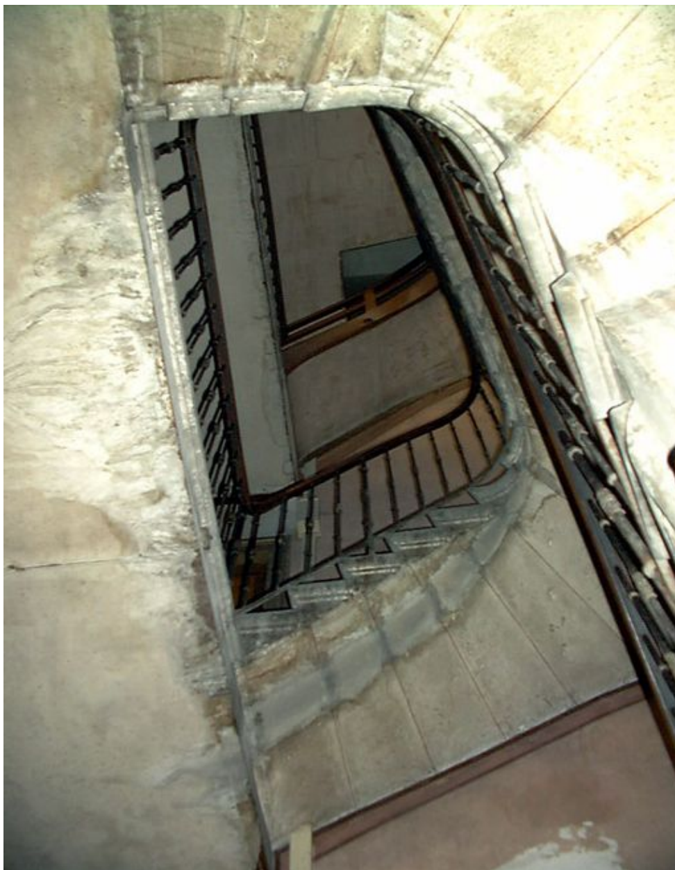
Escalier, jour vu depuis le rez-de-chaussée
