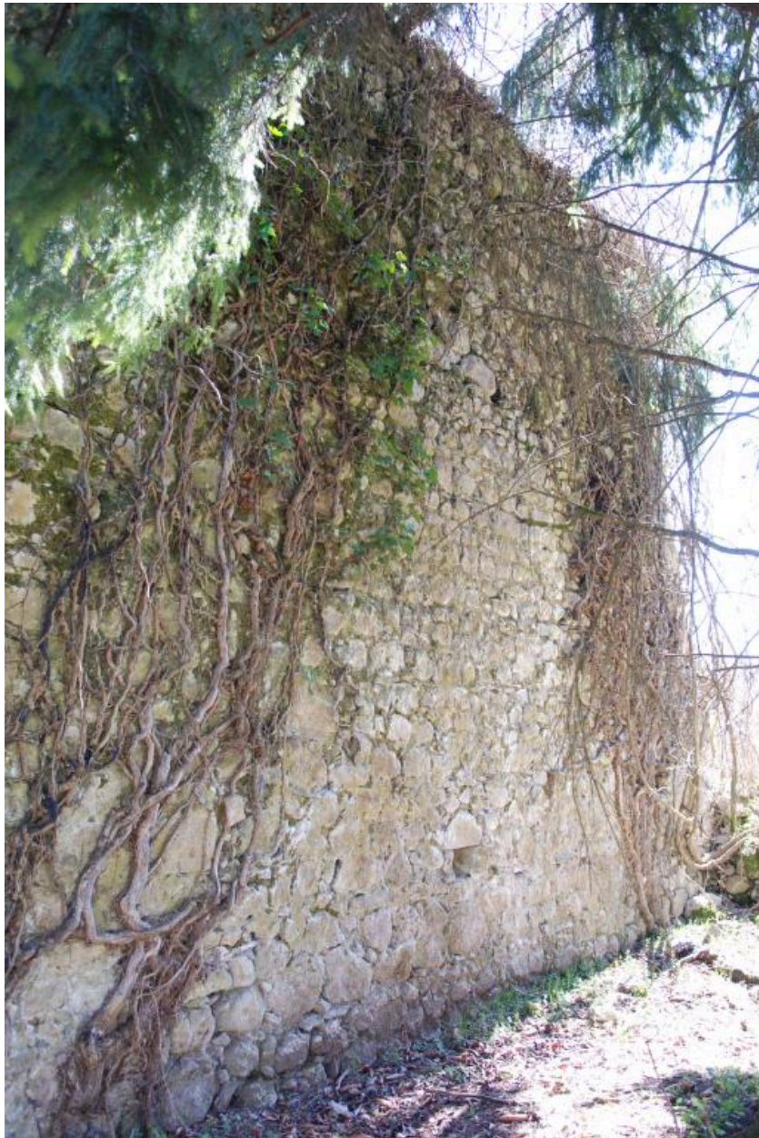
Château, élévation extérieure est des murs, vue d'ensemble de l'élément droit.
