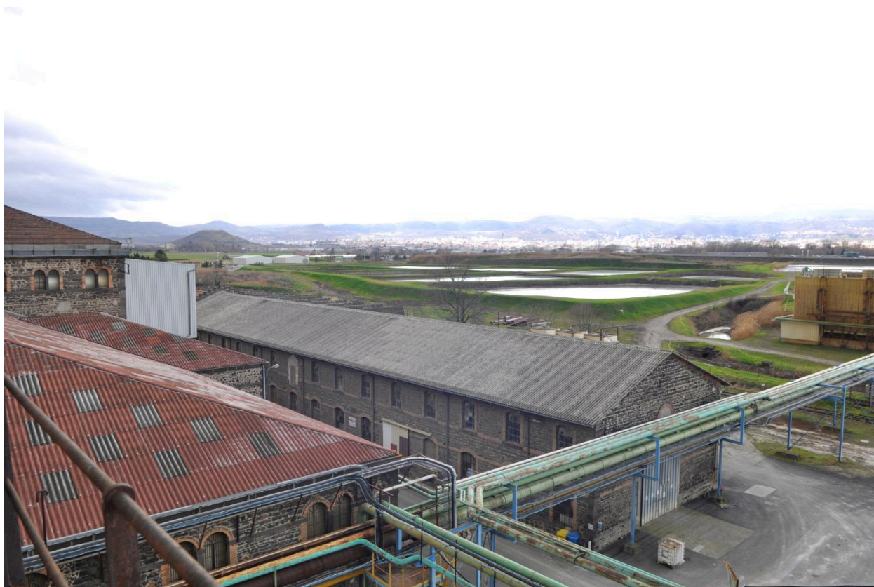
Vue de l'extérieur
