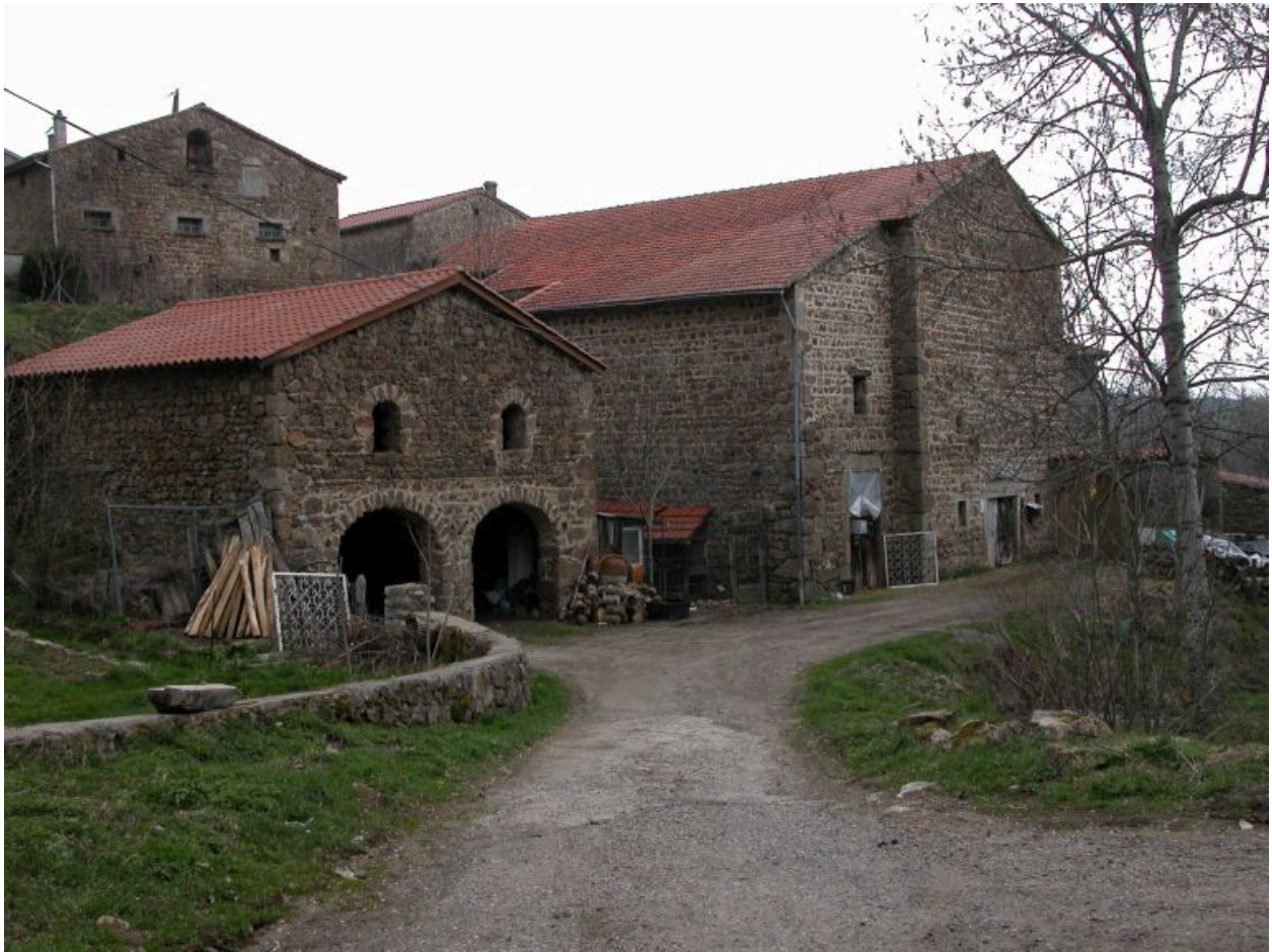
Vue d'ensemble de la ferme, de trois quarts sud-ouest, au premier plan la remise isolée.
