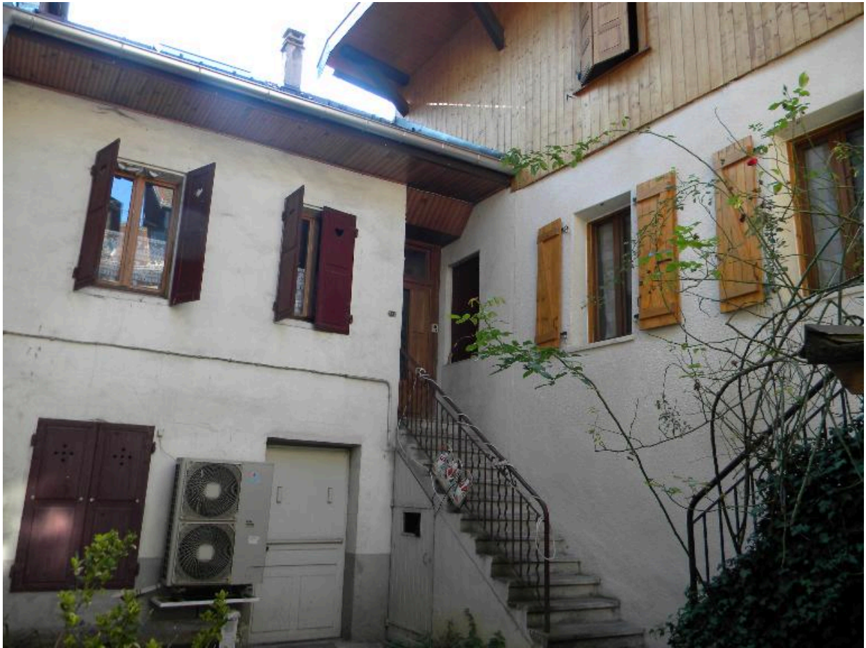
Cour intérieure angle nord-est (2008 D15 2455, 2463).
