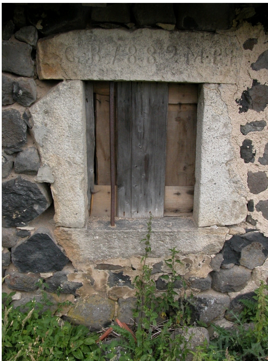
Détail de la fenêtre de la logette.
