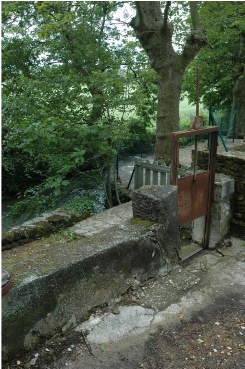
Les Fournaches. Vue nord du canal et de la vanne.
