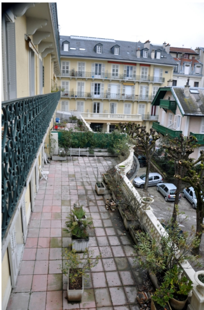
Terrasse en couverture de la salle à manger, partie ouest
