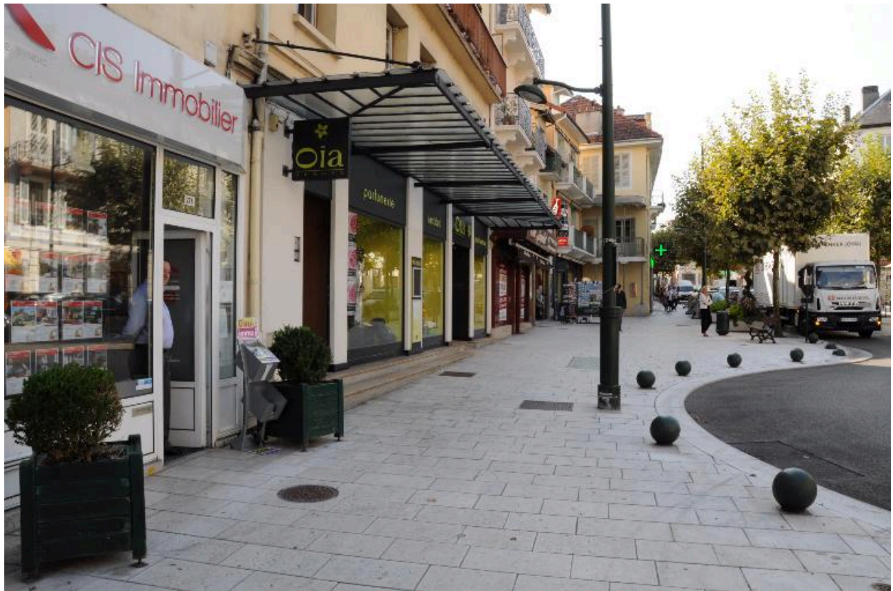
La marquise, vue depuis le nord
