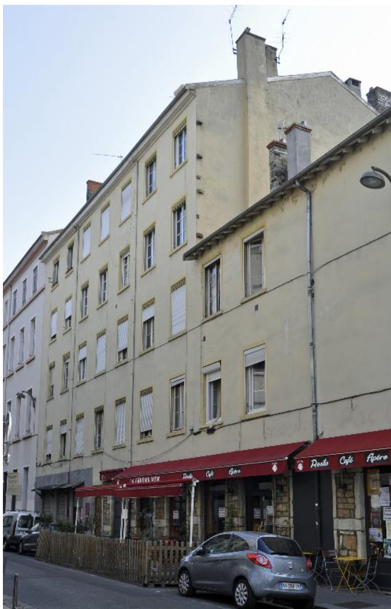
Immeuble sur rue, élévation antérieure
