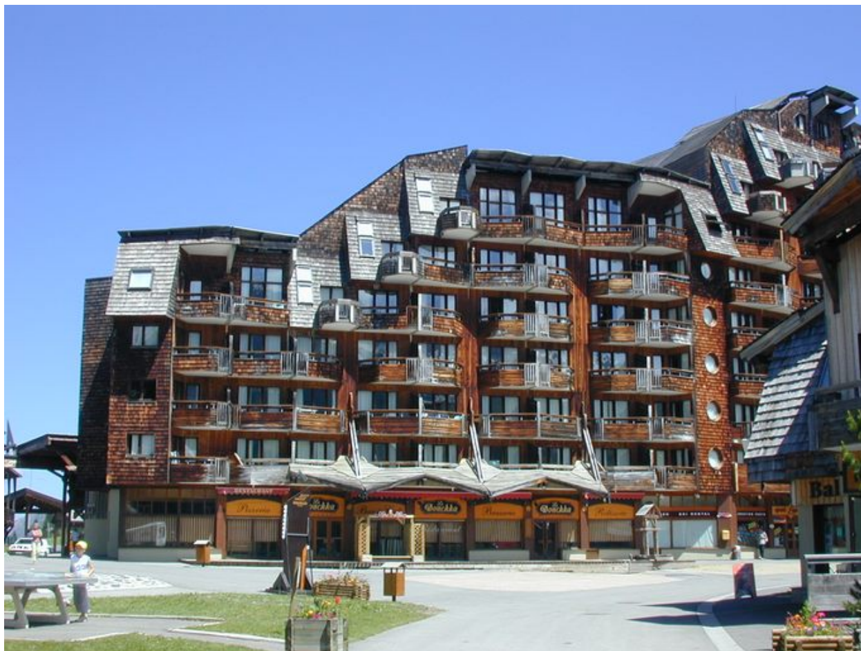
La façade sud, parties gauche
