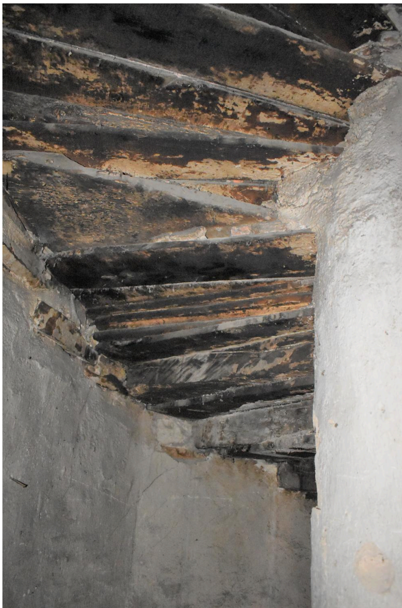
Etage de comble. Escalier en vis en bois vu en dessous.
