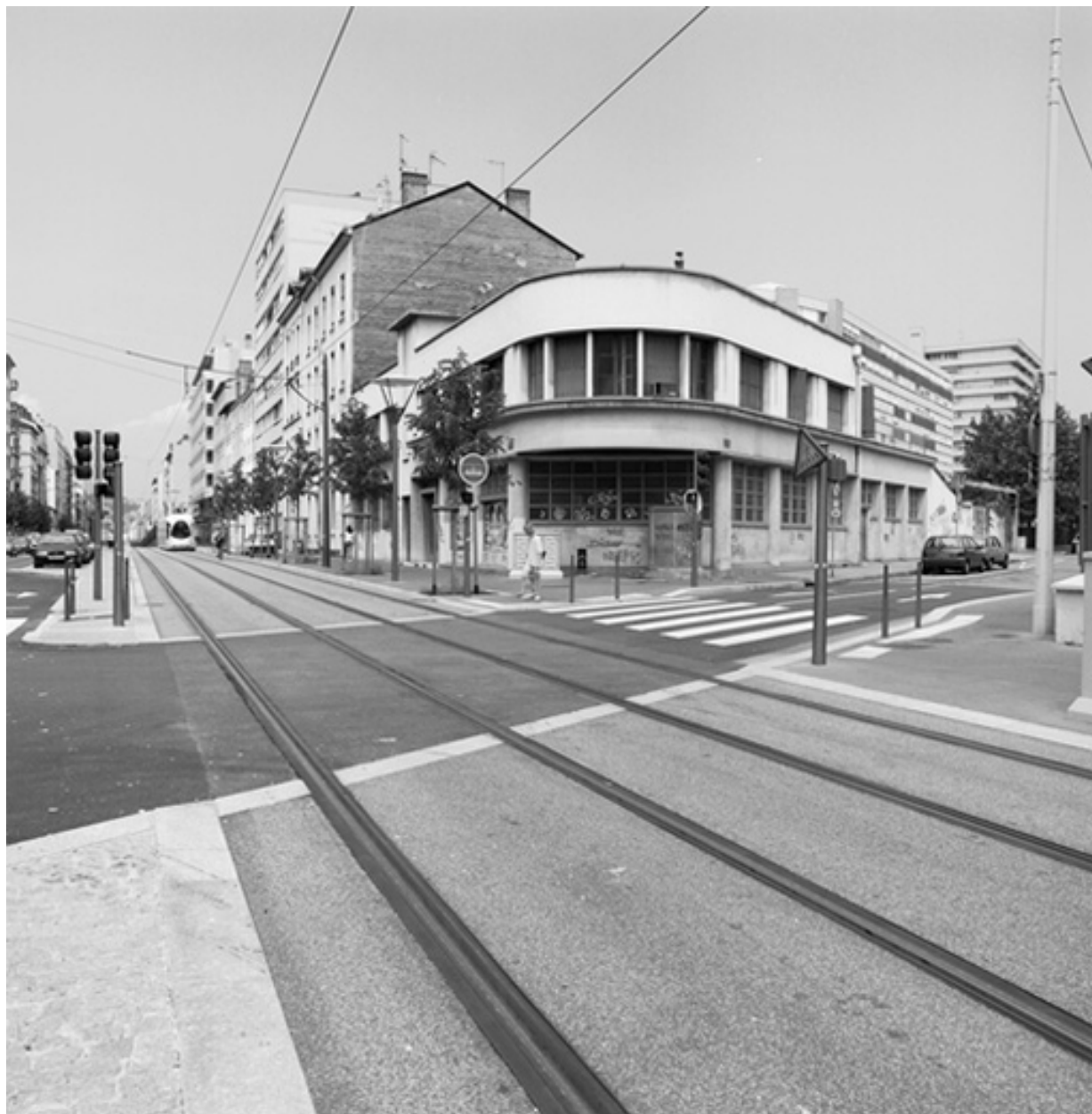
Vue d'ensemble sud-est
