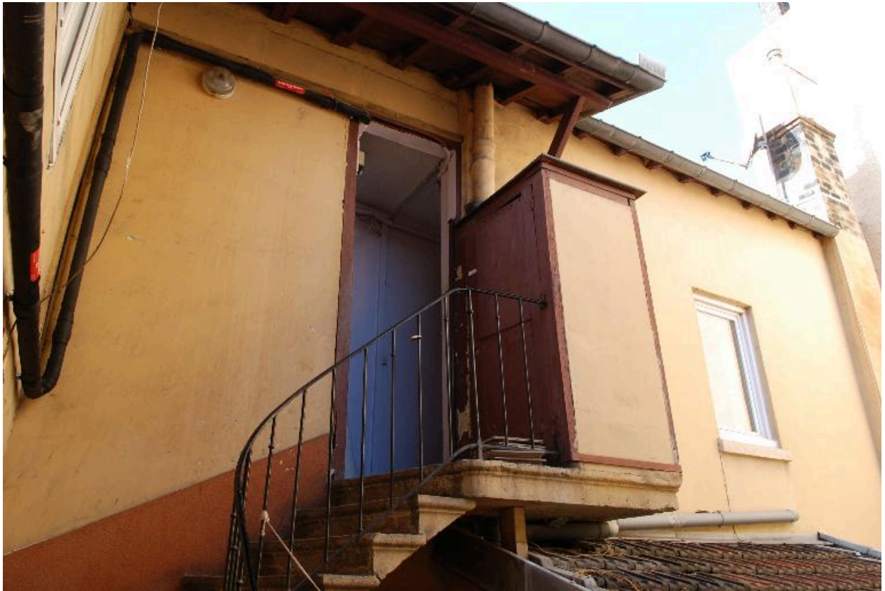
7 rue Féliissent : palier du troisième étage desservi par la coursière
