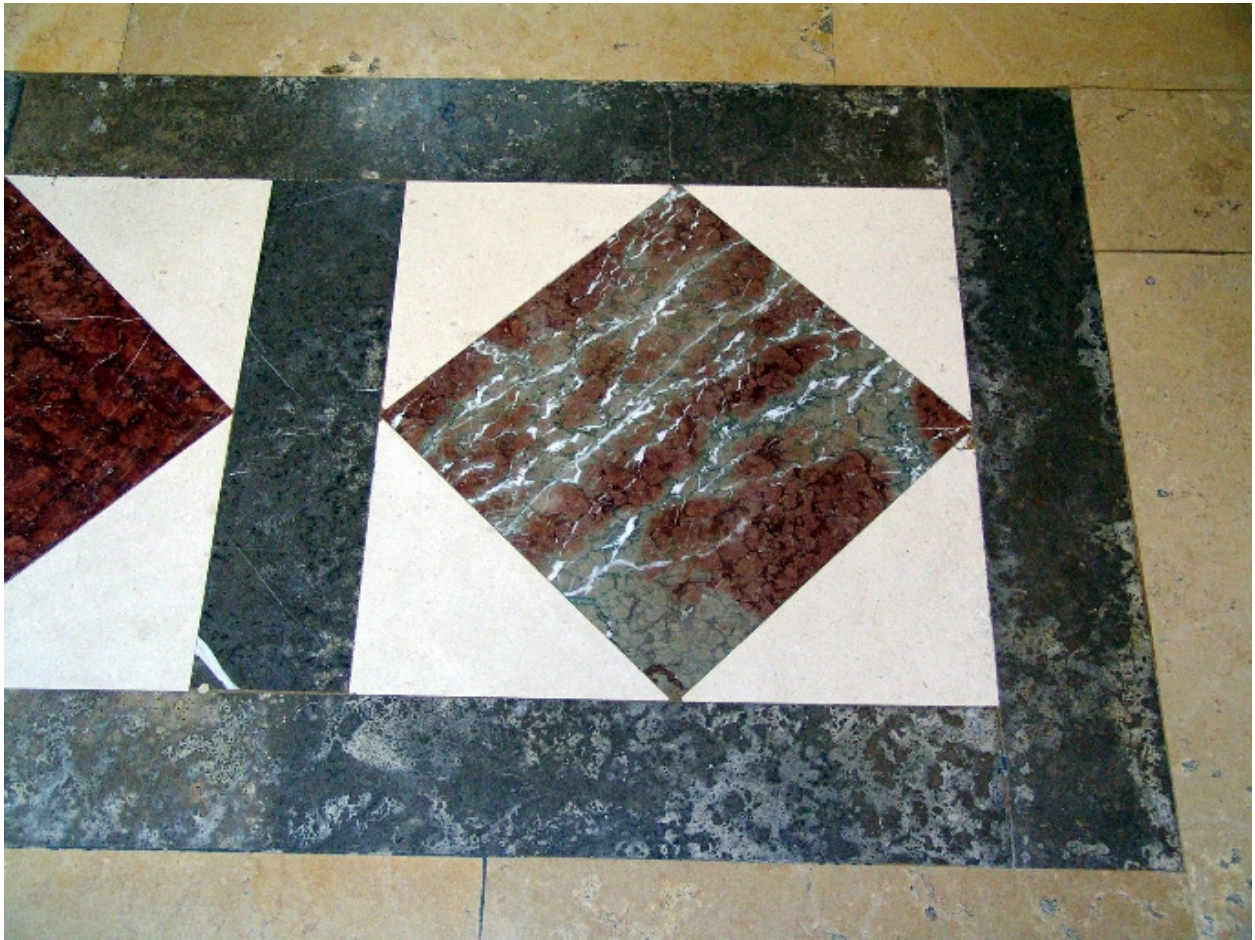
Sol du rez-de-chaussée surélevé : marbre de la Vermaz, pierre de Seyssel, marbre de Lemenc ou Curienne
