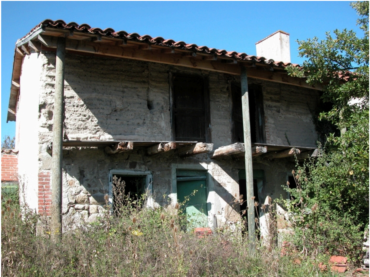
Logis avec aître à la Cave (1986 A2 126), vue d'ensemble.
