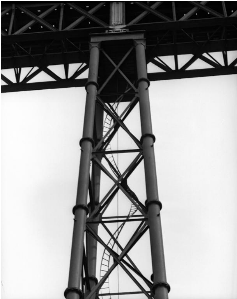
Détail de l'une des piles soutenant le tablier métallique.
