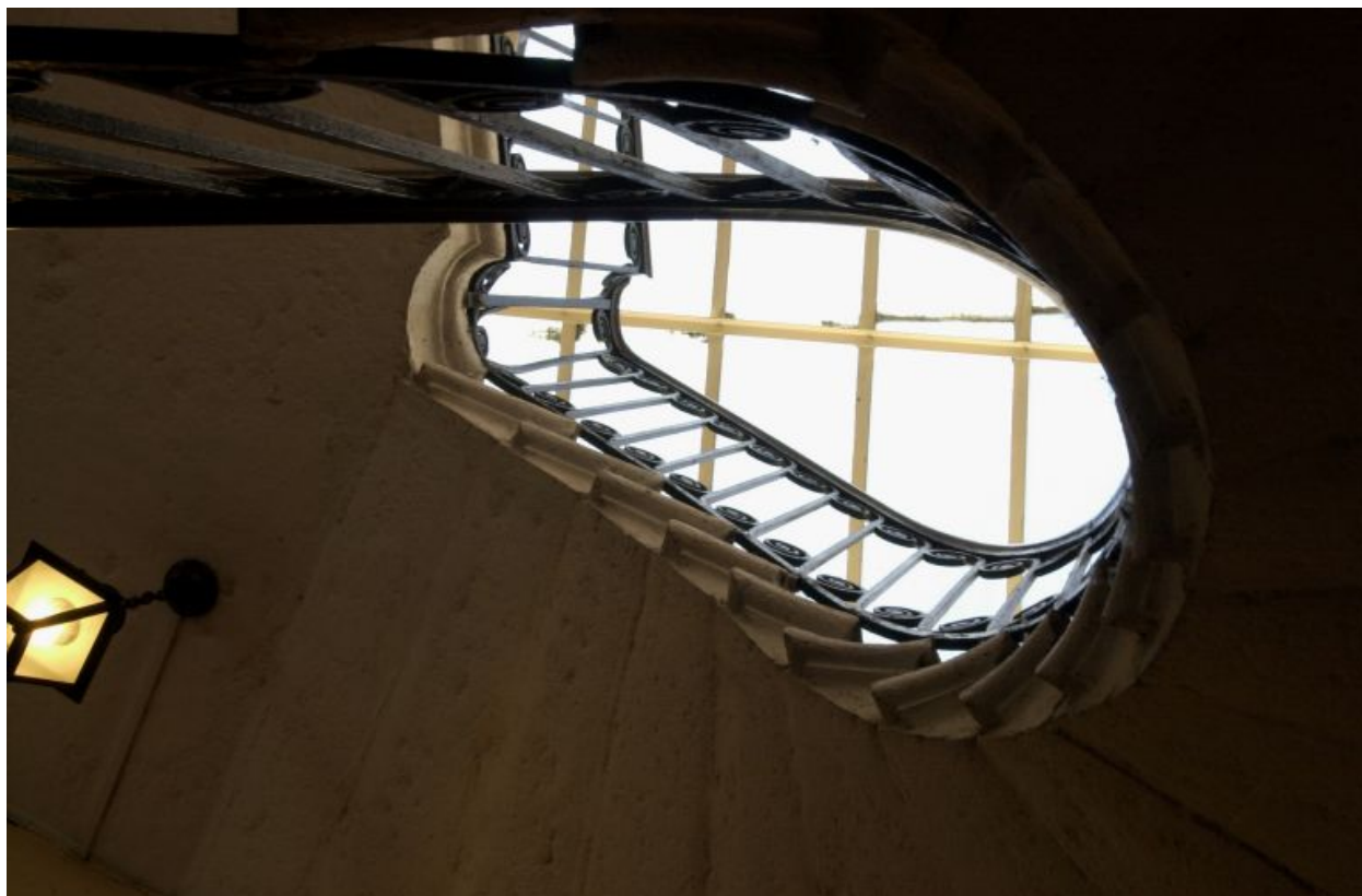
Partie haute de l'escalier
