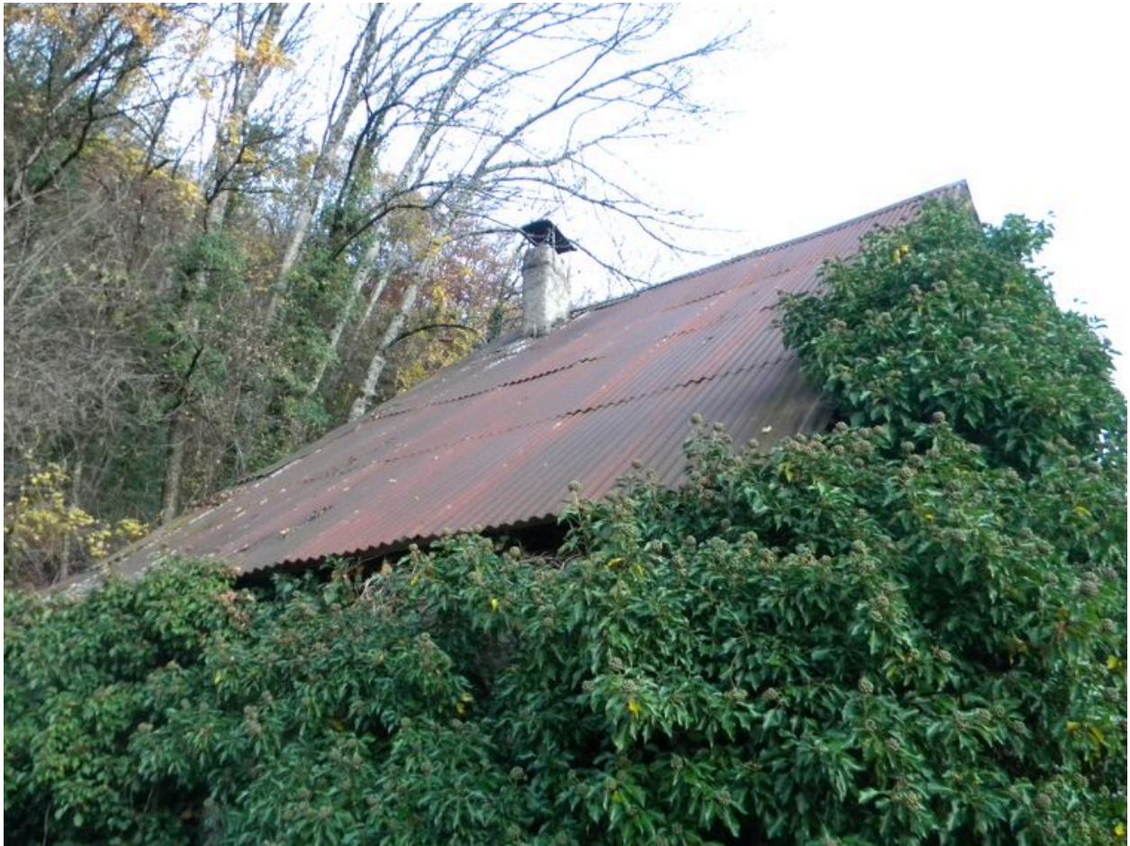
Vue de la toiture couverte en tôle ondulée.
