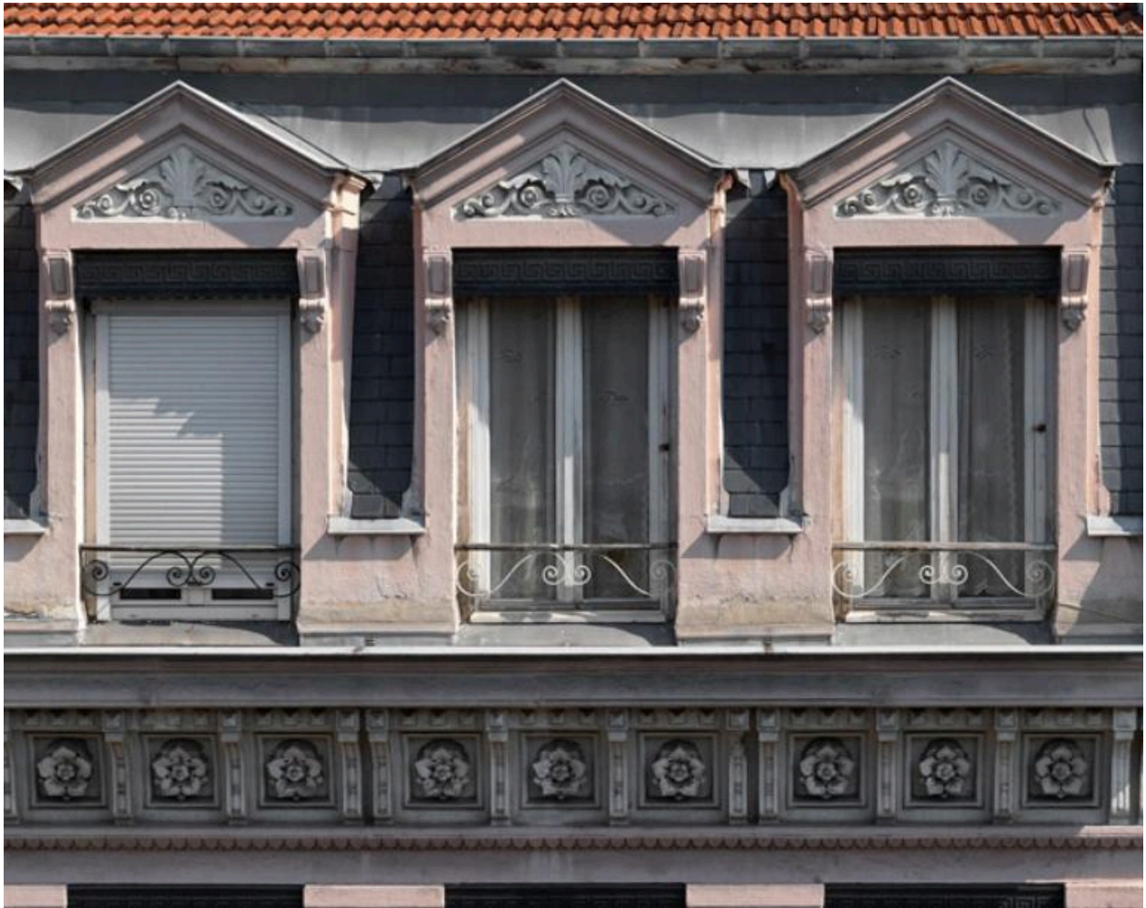
Vue partielle de l'étage de comble
