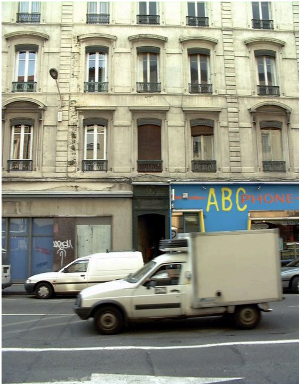
Elévation antérieure : le rez-de-chaussée et les premiers étages carrés
