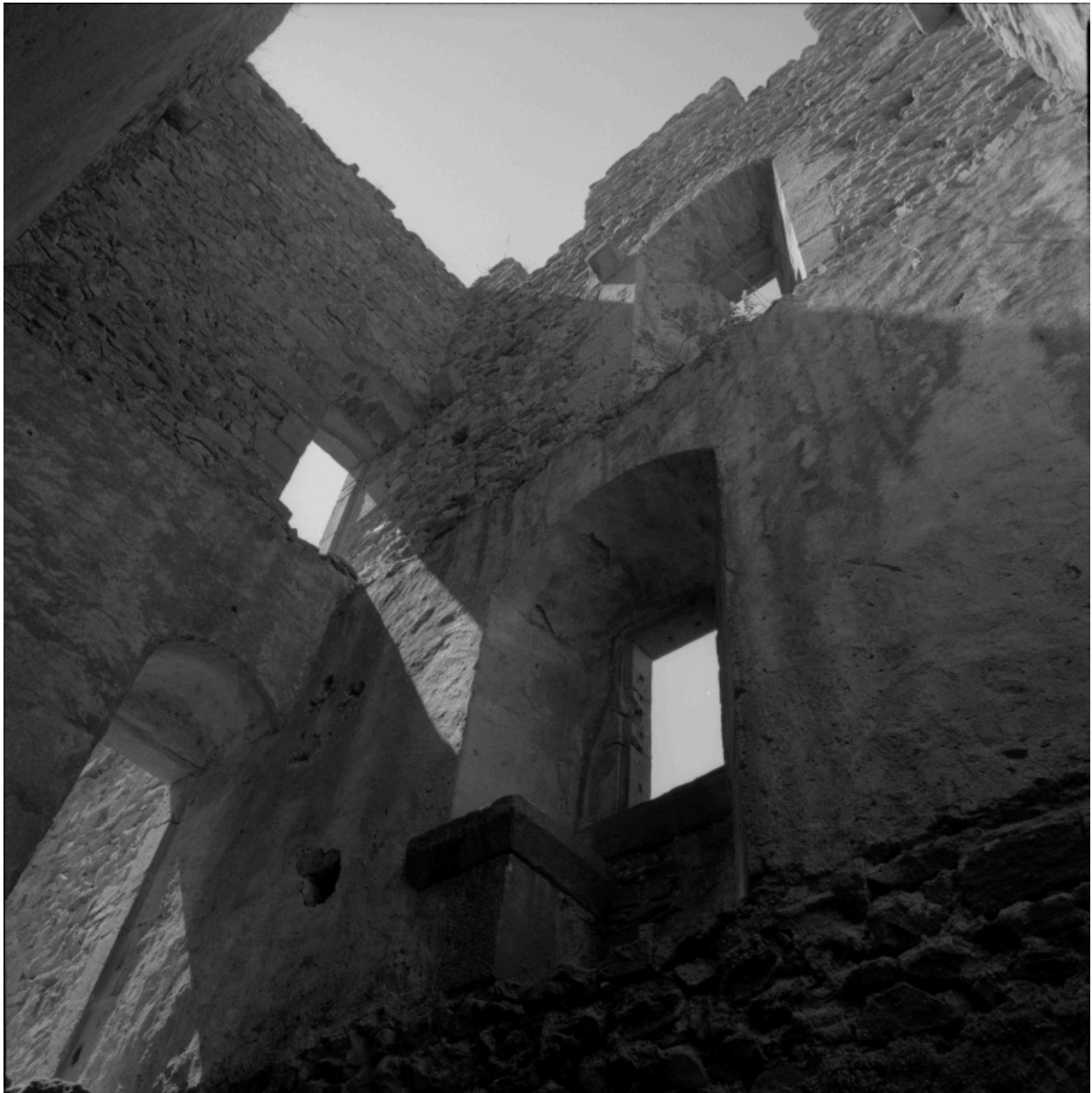
Ouvrage avancé du château fort primitif, tour carrée dite tour des Arrêts : vue en contreplongée des murs nord-ouest et nord-est, du nord.
