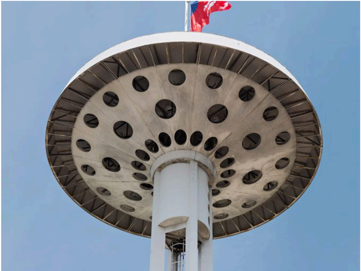
Partie sud de la piscine : détail d'un pylône (état en juin 2012).
