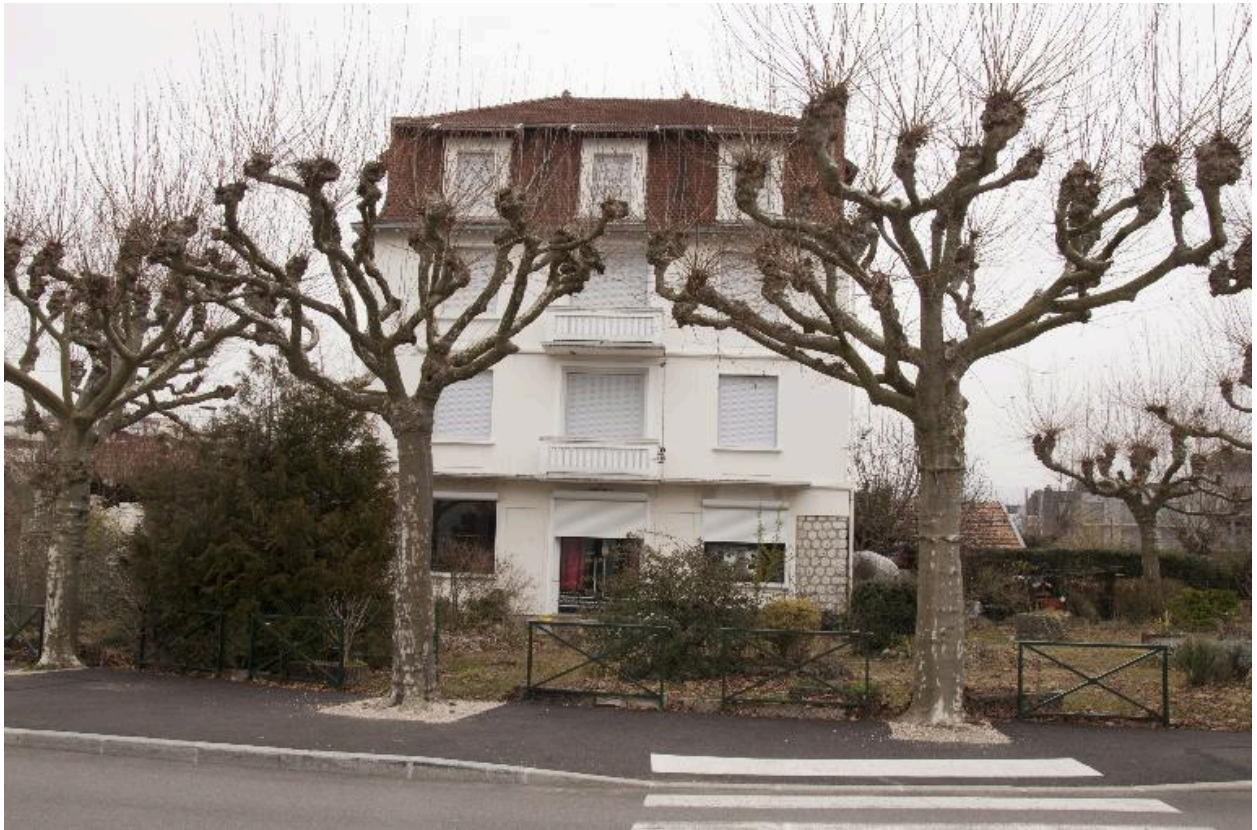
Immeuble Besson : façade ouest
