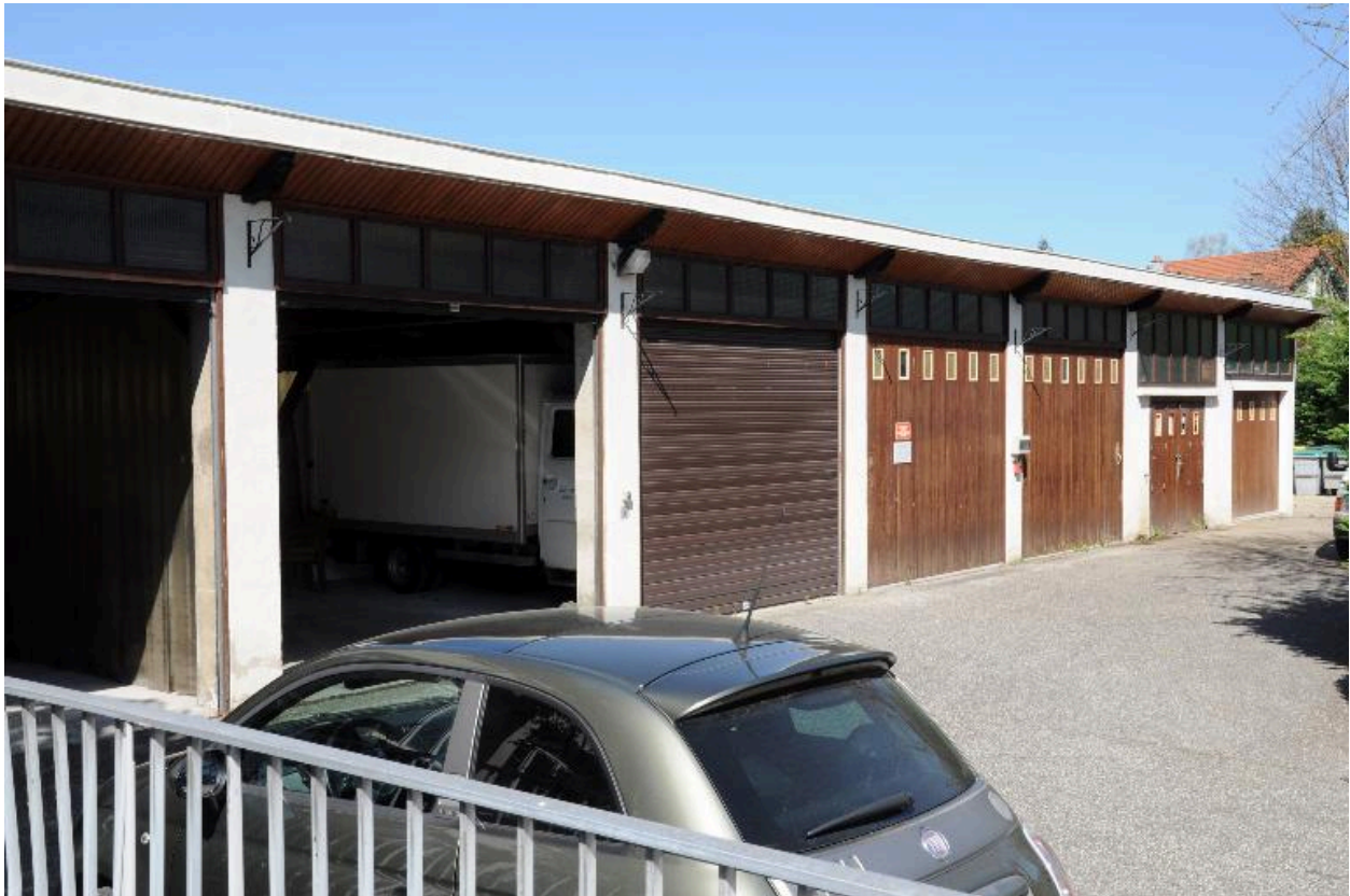
Garages (bât. K)
