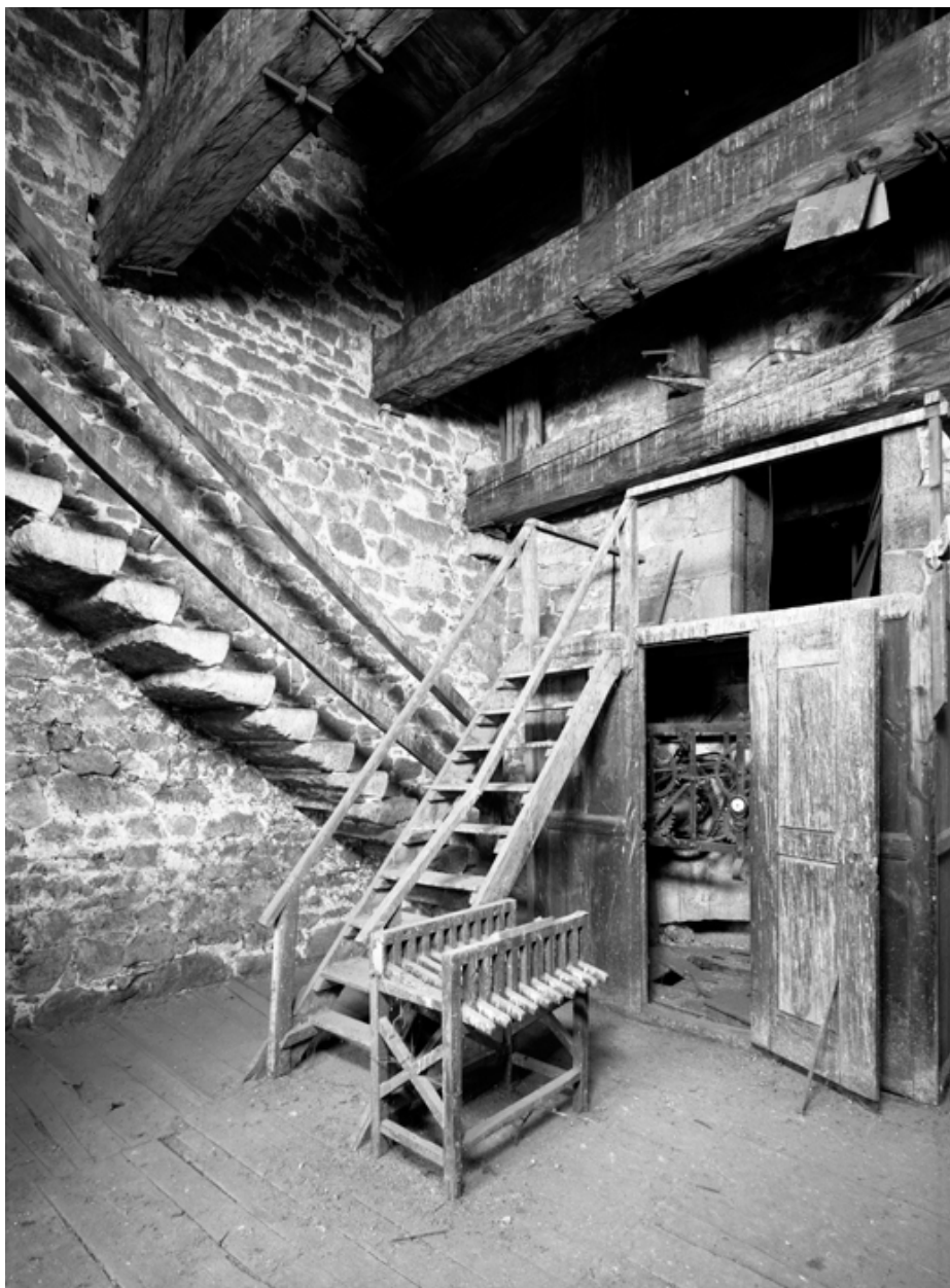
Clavier du carillon mécanique avant restauration, 3e niveau du clocher
