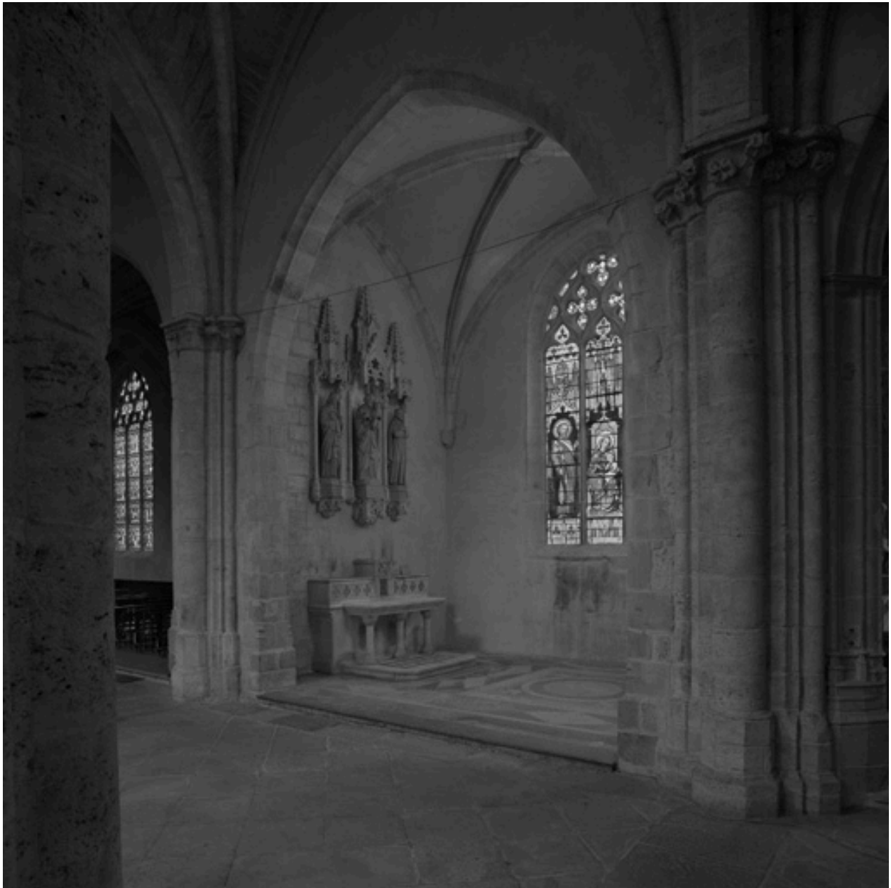
Vue générale de la chapelle 2.
