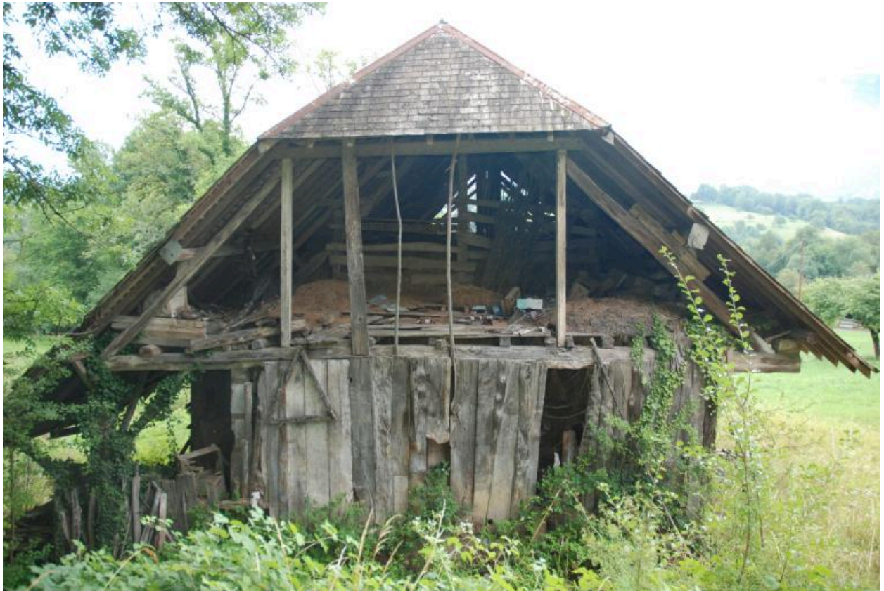
Vue du mur pignon ouest.
