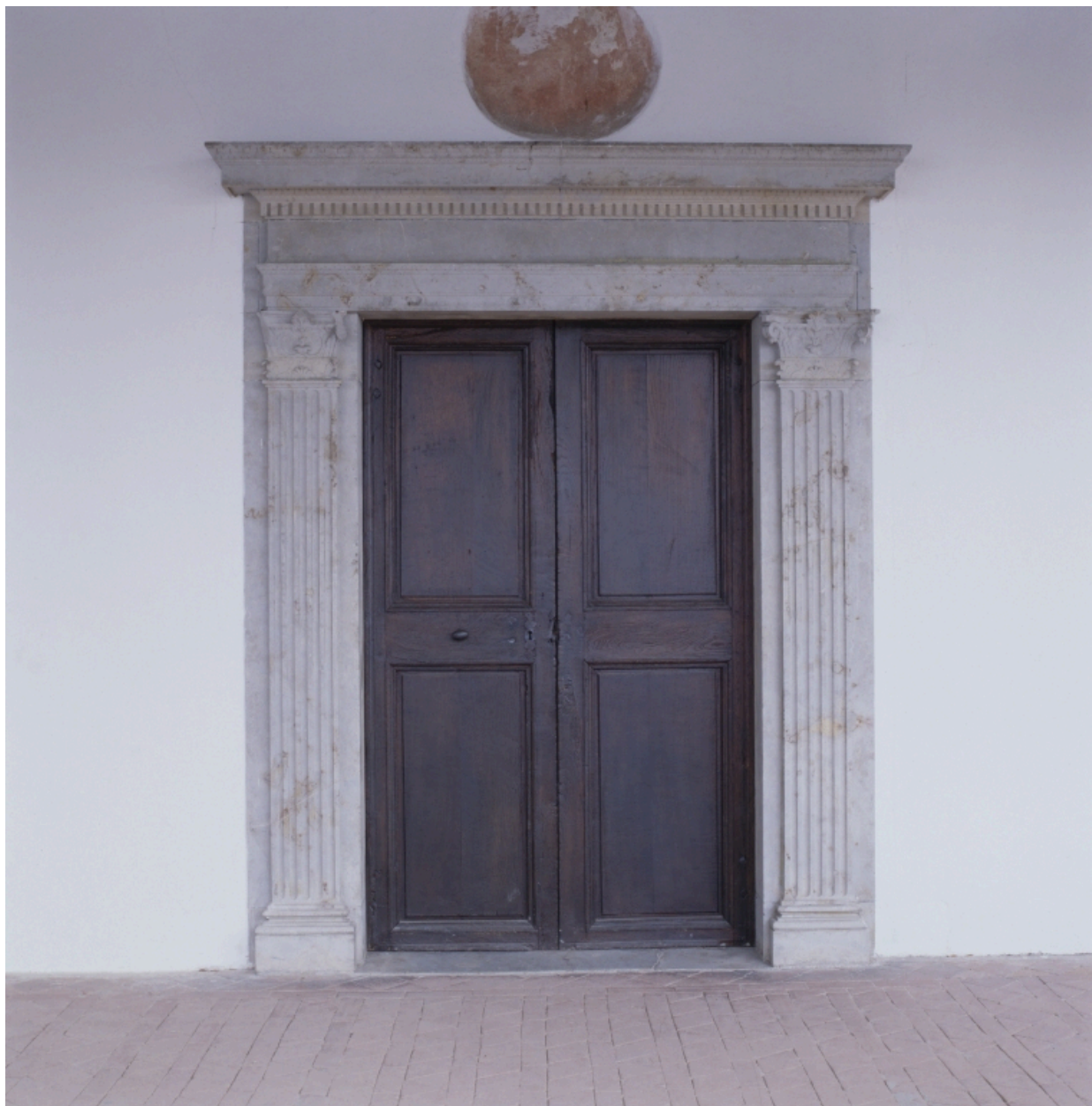
Vue de la première porte du grand salon ouvrant sur la galerie (le tympan a disparu).
