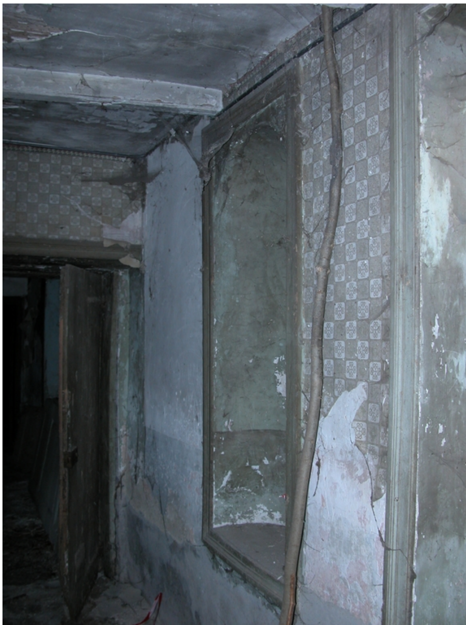
Vue intérieure du rez-de-chaussée : niche dans le mur du couloir.
