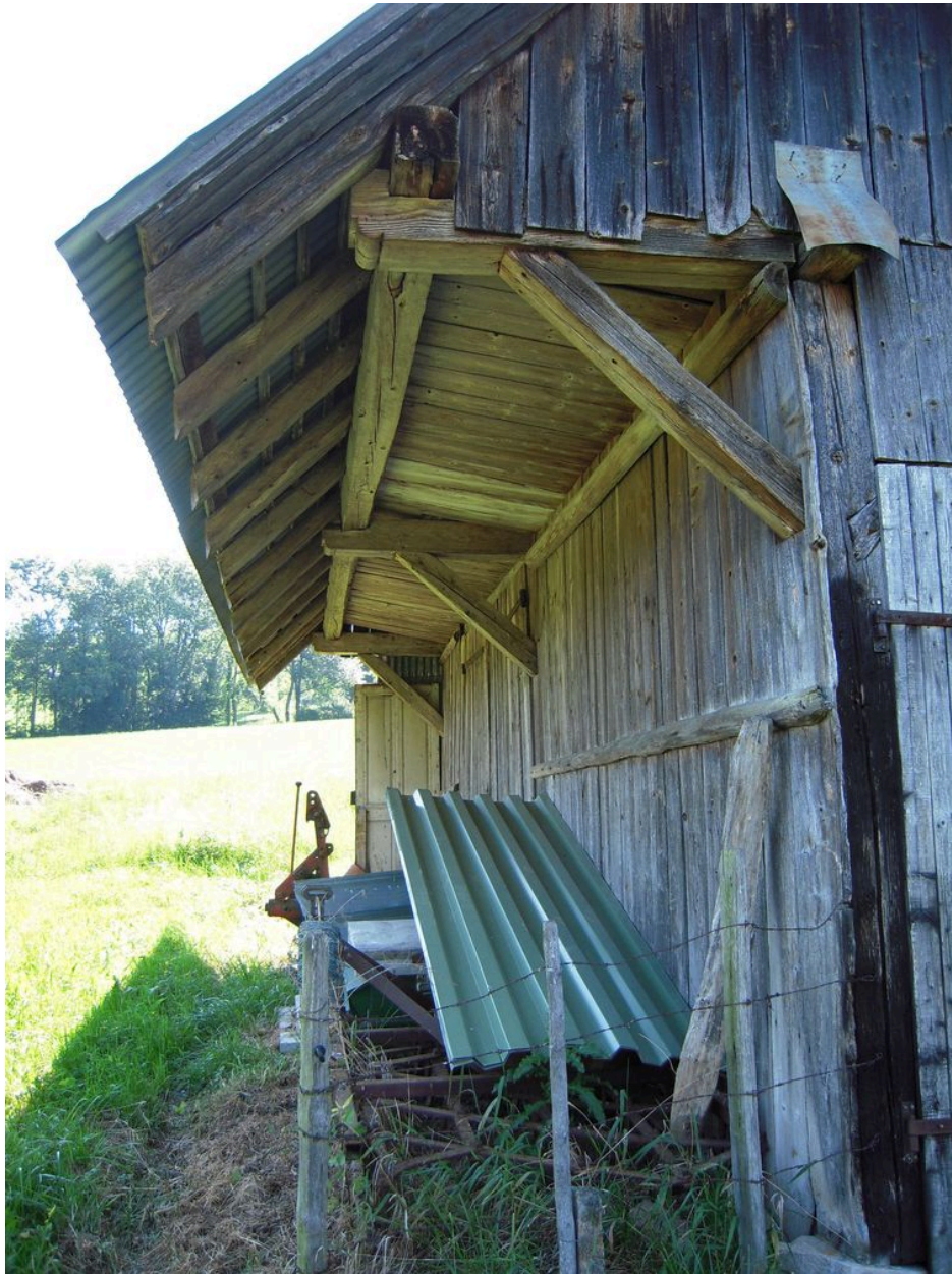
Vue de la dépassée de toit sur la façade nord.
