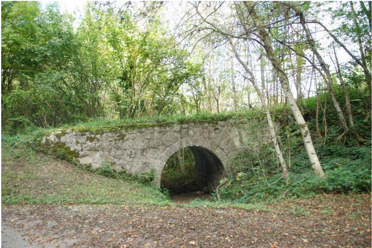
Varnaz (commune de Pugny-Chatenod), NC (vers 2014 B4 529), pont du train à crémaillère enjambant un ruisseau.
