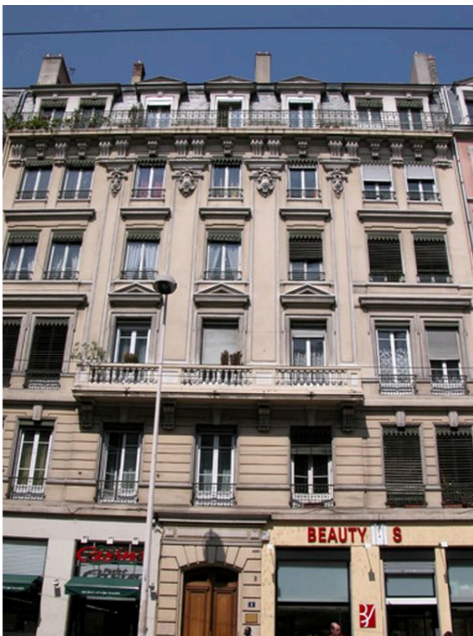
Détail de la travée centrale
