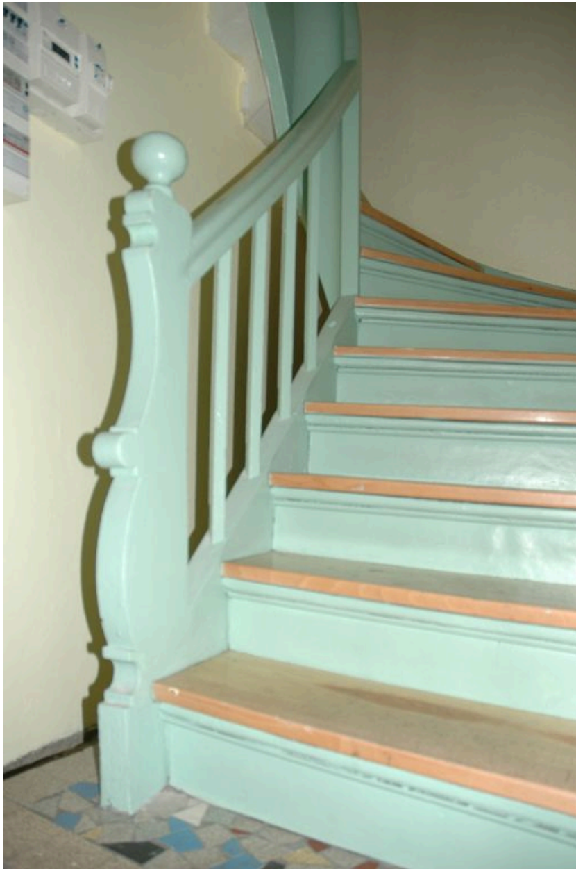
Départ de l'escalier en bois.
