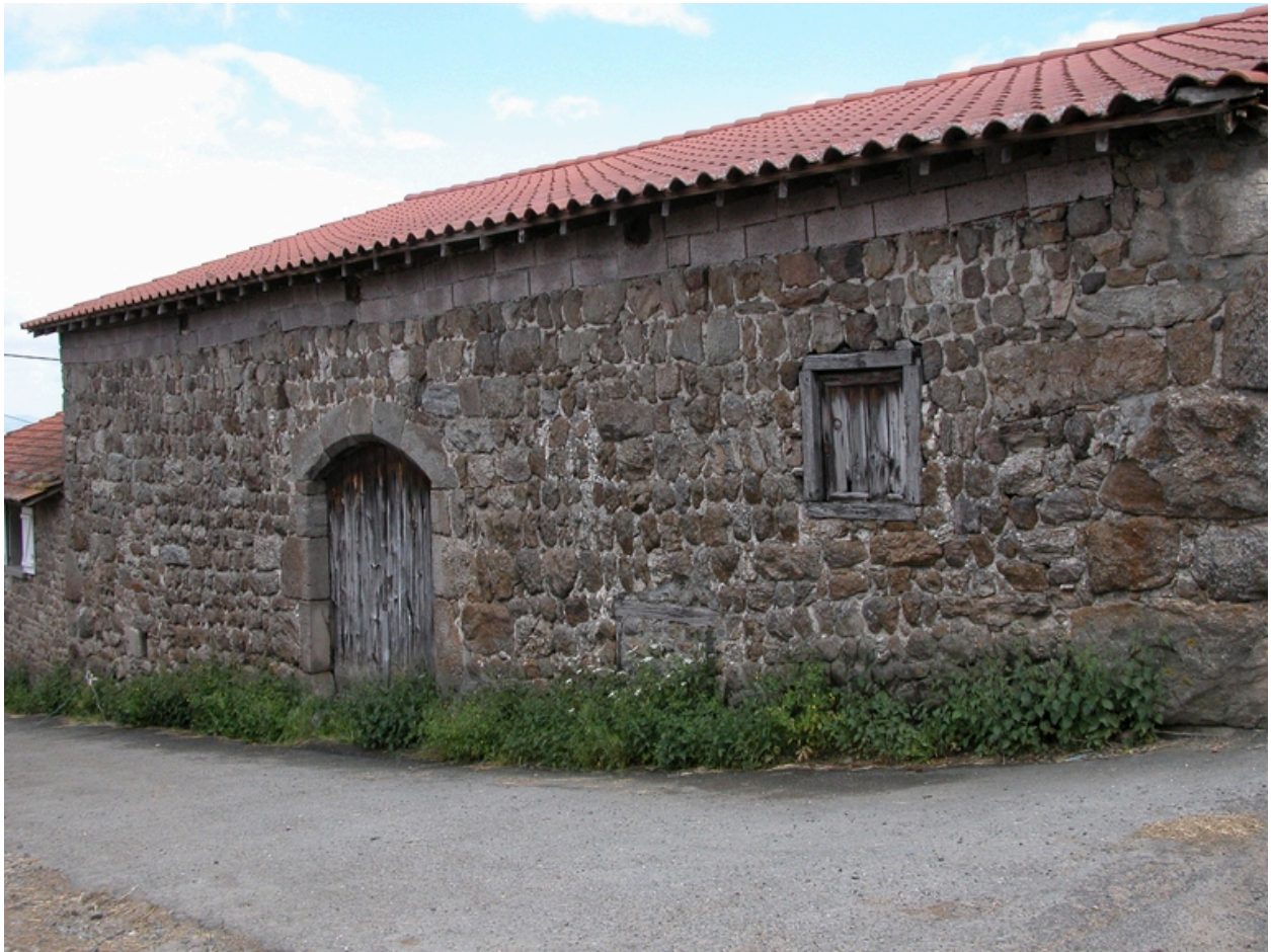
Ferme à Mérigneux (1986 D 371), vue arrière de la grange-étable.
