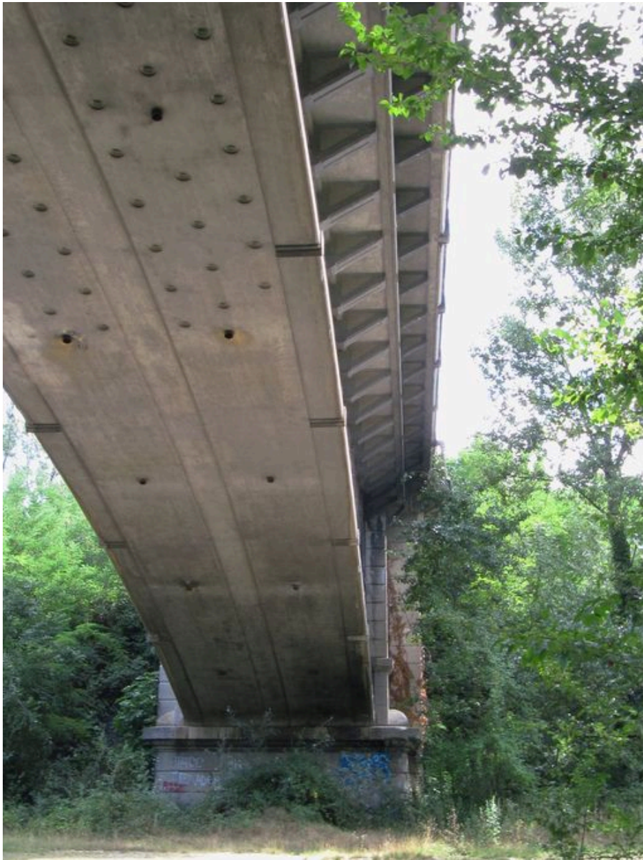
Vue partielle, de dessous, arche et culée gauche, face aval (depuis la rive gauche)
