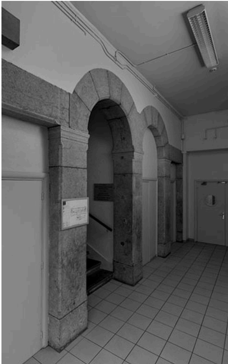
Encadrements en pierre de taille, départ de l'escalier nord du bâtiment des services généraux
