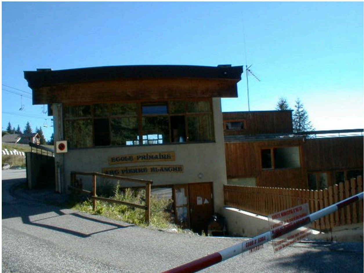
Façade principale (nord-est)
