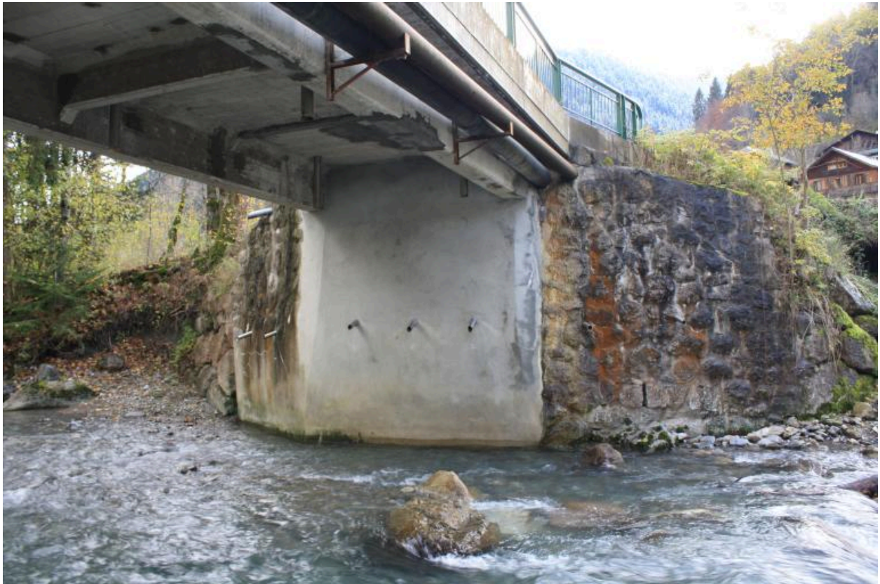
Pond de Sous Saint-Jean, culée rive gauche
