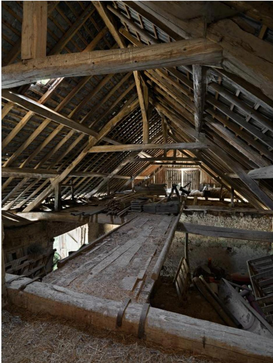
Vue du comble sous charpente : pont roulant du fenil.
