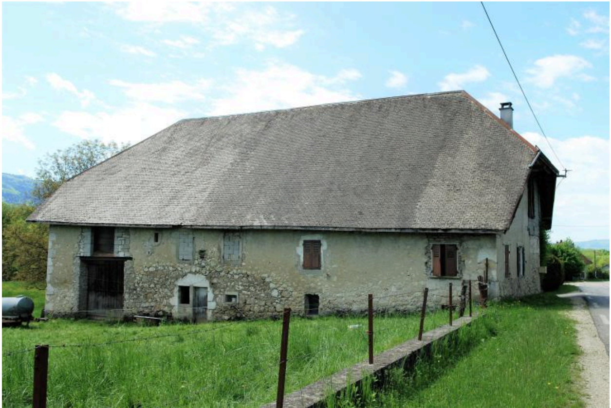
Vue générale arrière du bâtiment.
