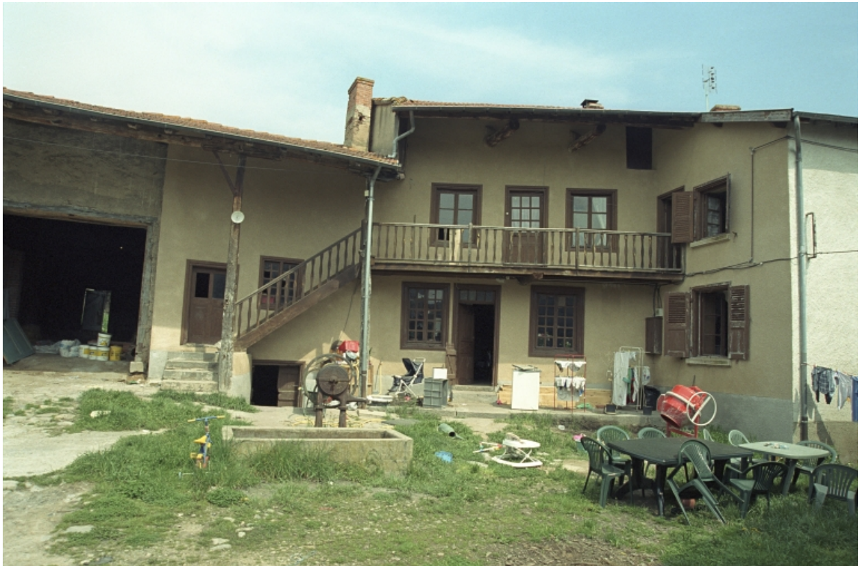
Premier ensemble. Bâtiment nord : vue d'ensemble du logis actuel.
