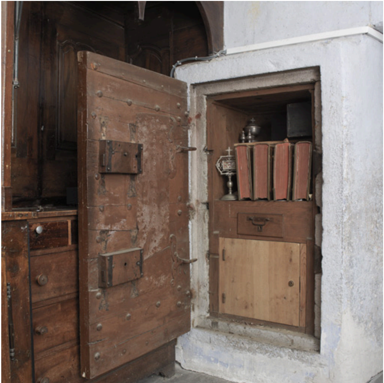
Vue d'ensemble (porte ouverte).
