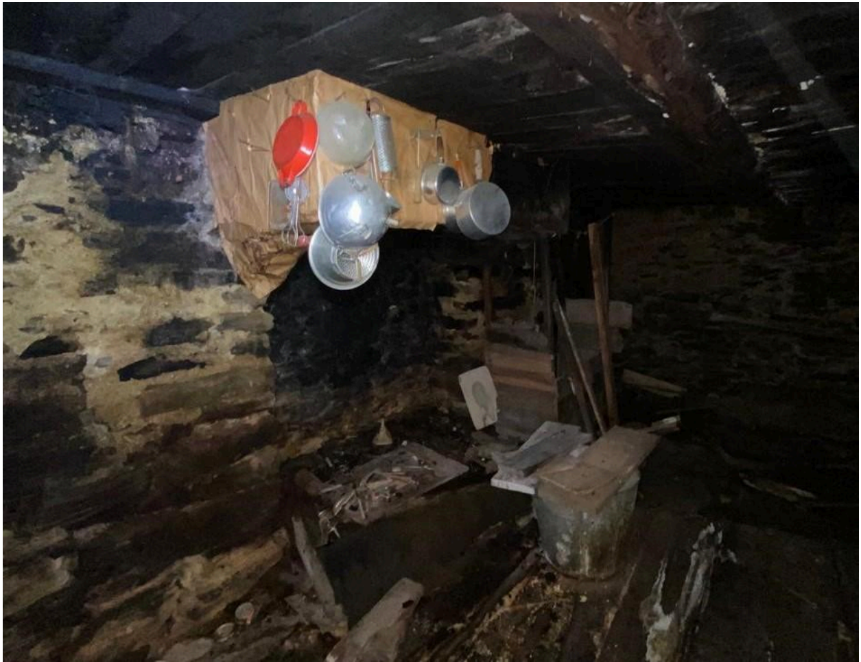
Niveau semi-enterré : cheminée (âtre) cuisine d'été
