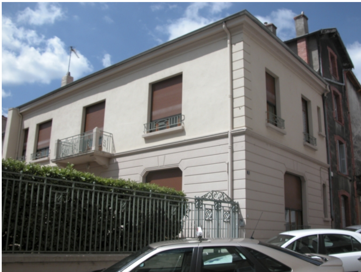
Îlot 9. Vingtain (rue des). Vue partielle de la façade sur la rue.
