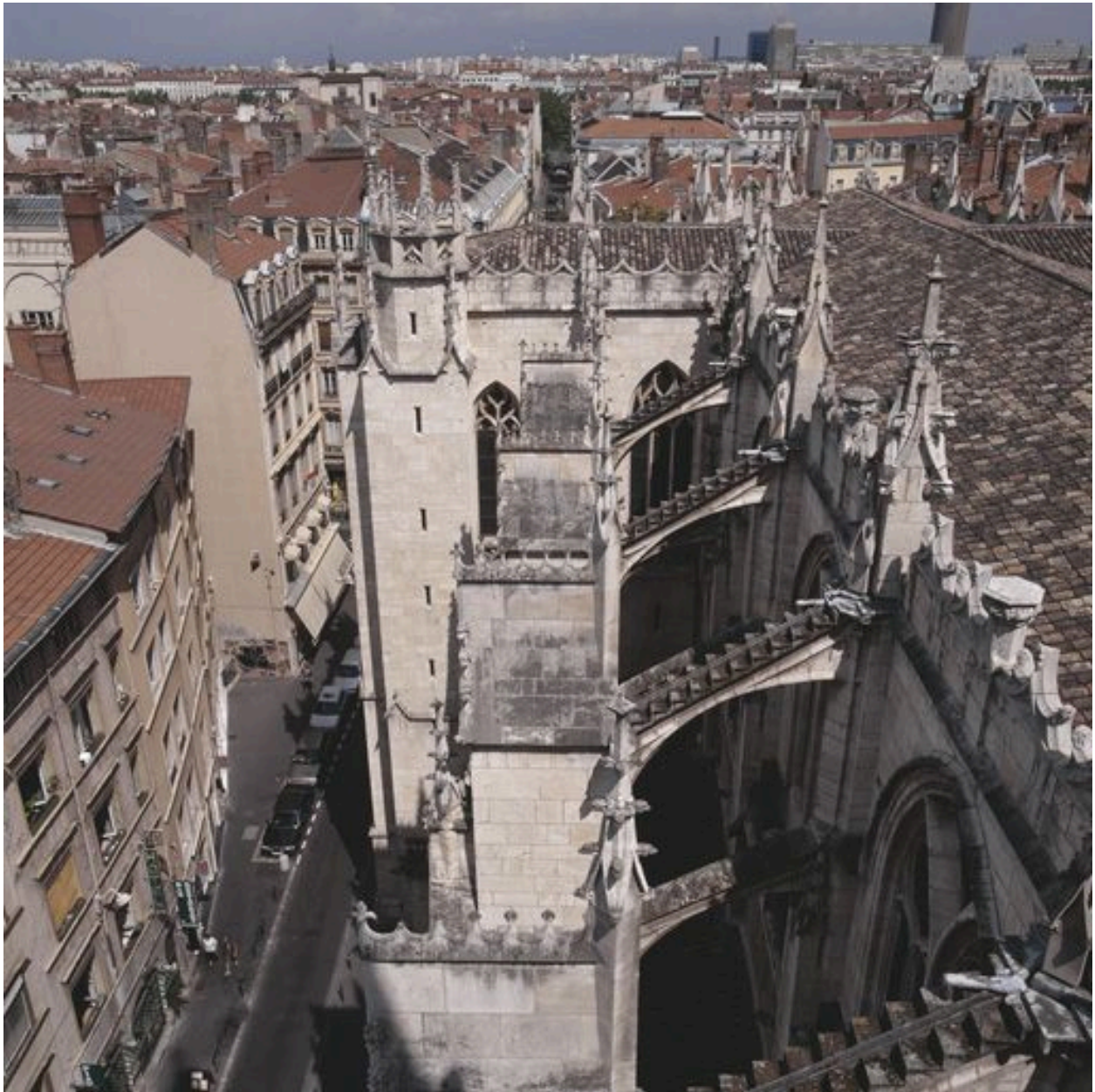
Elévation nord de la nef, vue générale du système de contrebutement du vaisseau central
