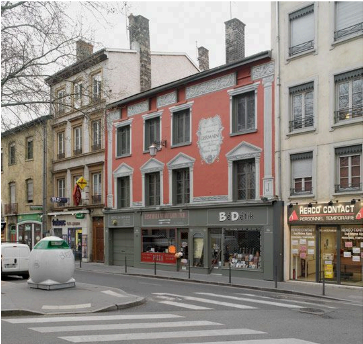
Vue d'ensemble après restauration
