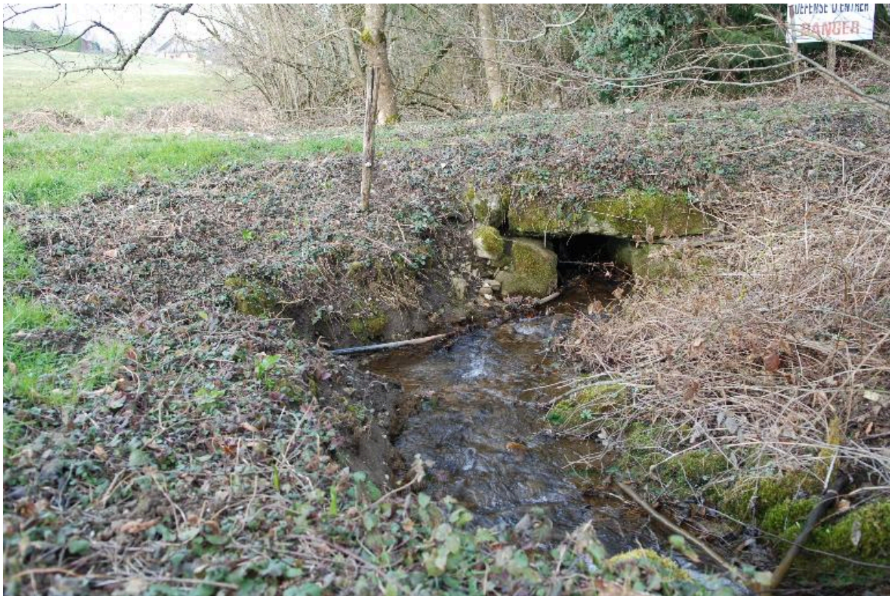
A4 (NC) vers 387 / A3 (NC) vers 911, Delà le Nant, lavoir. Vue d'ensemble du lavoir
