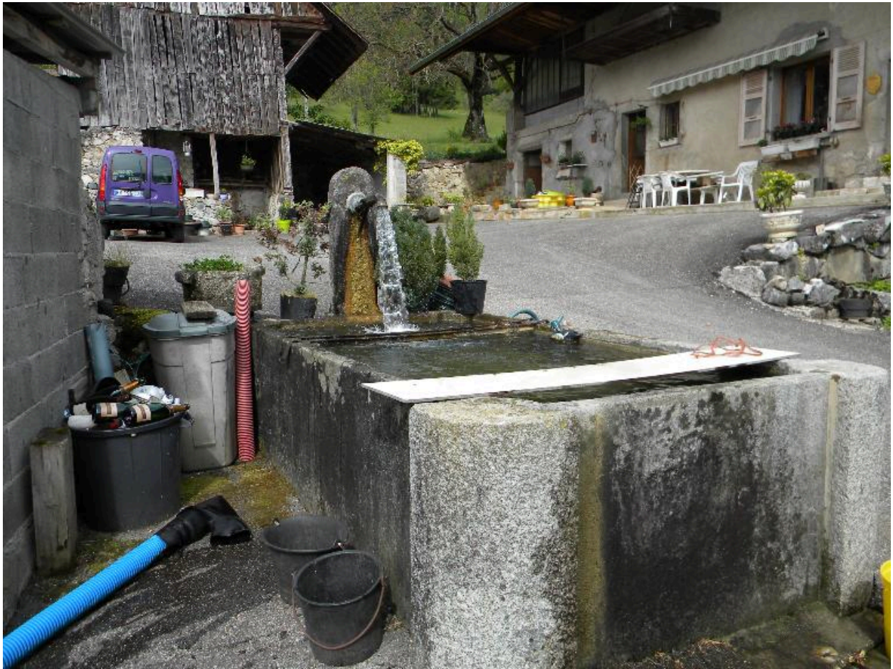
Vue rapprochée du bassin chemin de la ferme
