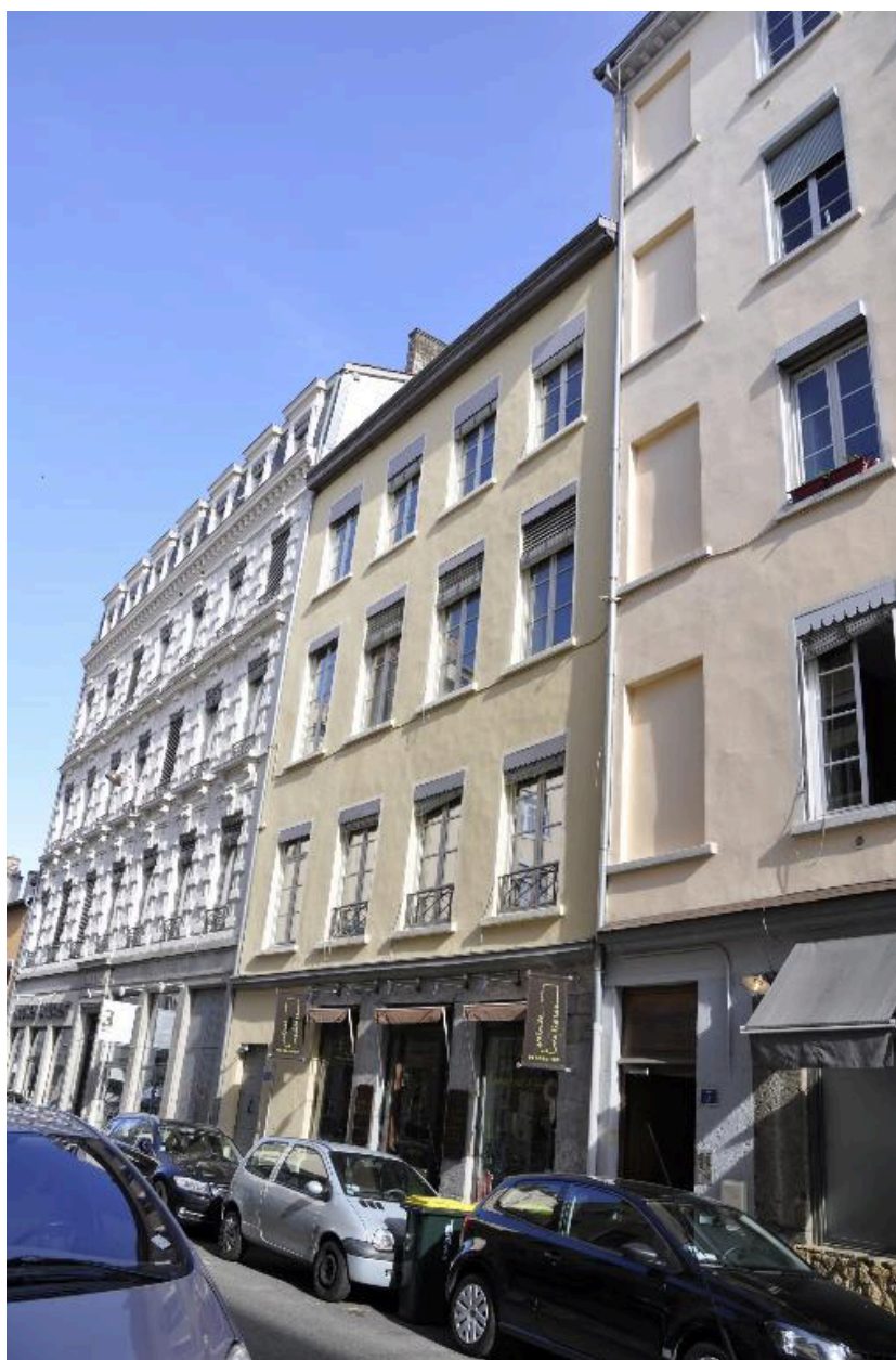
Vue d'ensemble sud est
